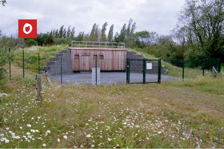
Bild 1 (links): Hochbehälter Höhr der Ver- bandsgemeinde- werke Bad Ems. © Roth
