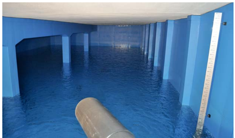
Bild 9: Wasserkammer eines Behälters nach Sanierung. © Roth
